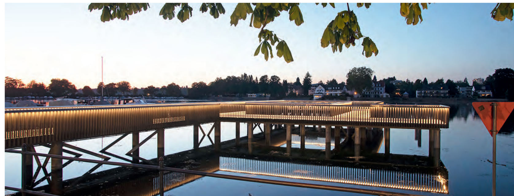
Die Objekt- und Tragwerksplanung des Nobelpreisträgersteiges im Kleinen See in Lindau entstammt aus dem Ingenieurbüro Fecher Werner Sauter.
